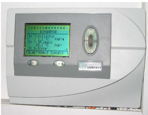
Zur Erfassung der Daten dient die bereits im Haus installierte Heizungs- und Solarsteuerung UVR1611. Sie hat 14 analoge Eingänge für Temperatursensoren, die Widerstände im Kilo-Ohm-Bereich zurückgeben. An einem freien Temperatur-Ausgang sind die zwei parallel verbundenen Fotowiderstände angeschlossen.
